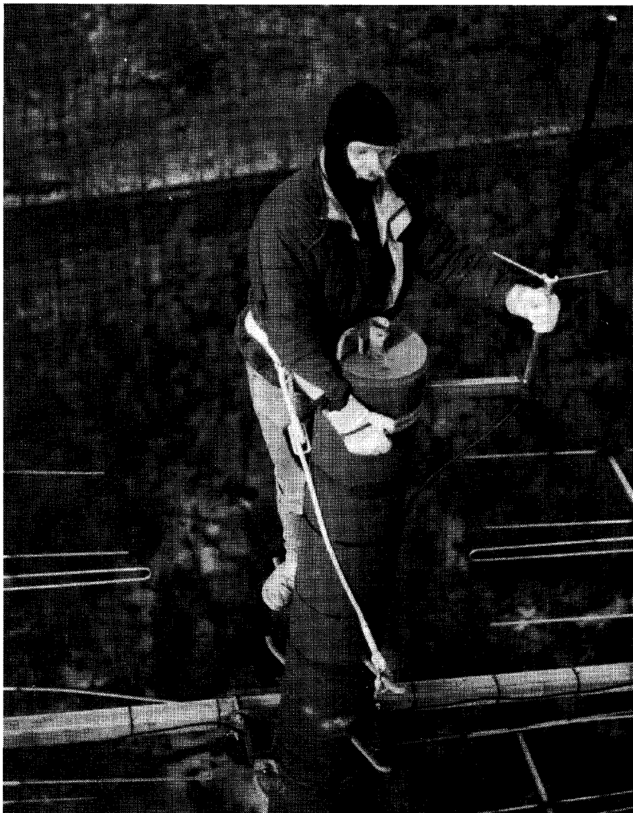
Het bevestigen van de 23 cm-antenne op honderd meter hoogte door Fred, PA3ETM en Max, PE1MHD. De bivakmutsen waren geen overbodige luxe tegen de snijende kou. Overigens: Redert, PAoNEK, zat nóg een tiental meters hoger om deze foto te maken...
